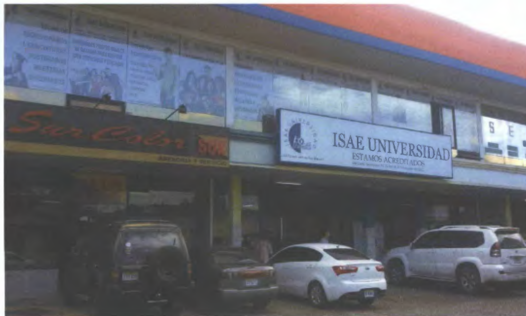
Fig. 28 Locales comerciales de Calle Novena
