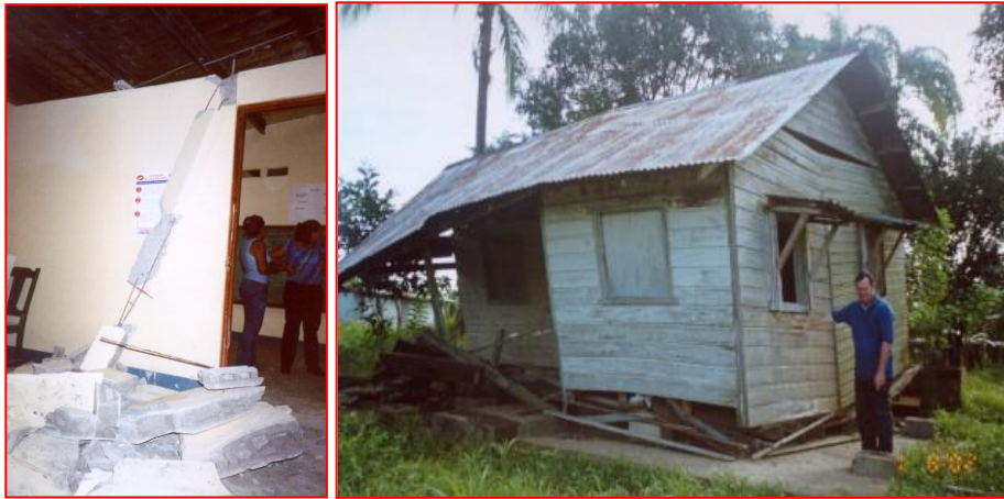
Figs. 5 y 6. Daños a estructuras en Puerto Armuelles, Panamá.
